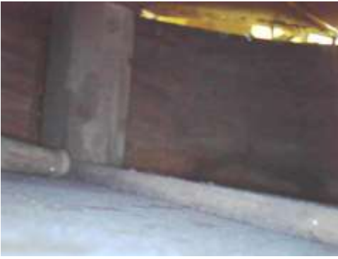
Yllä pohjapalkin pää pitkän sivun klossia vasten. Kuvan yläreunassa auennut peräsivu.
