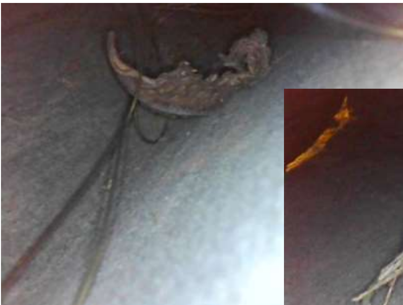
Kopan sisällä on kielilankaa, kuivunut lehti ja heinää. Alakuvassa näkyy pitkän sivun ja peräsivun kulmalta (vas. yläkulma) kansilevyn raosta valoa.
