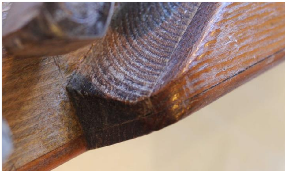
Vasemmalla lyhyen sivun, viritystappipenkin ja pohjan saumat.
