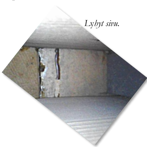
Väli­pohjan ja kannen välissä oleva rima ääniaukosta kärjen suuntaan kuvattuna.
