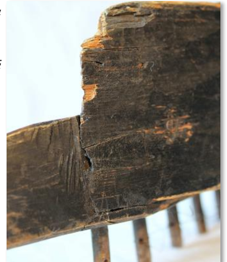
Kärjen alanurkasta on lohjennut pala.
