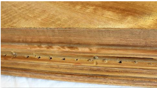
Viritystappipenkin alapuolella näkyvät viritystappien reiät.
